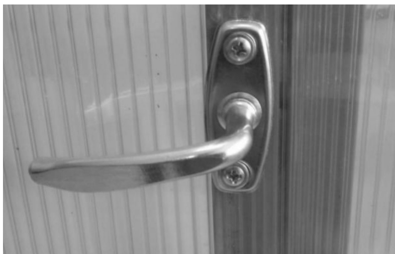
Рис. 4. Крепление ручки саморезами
