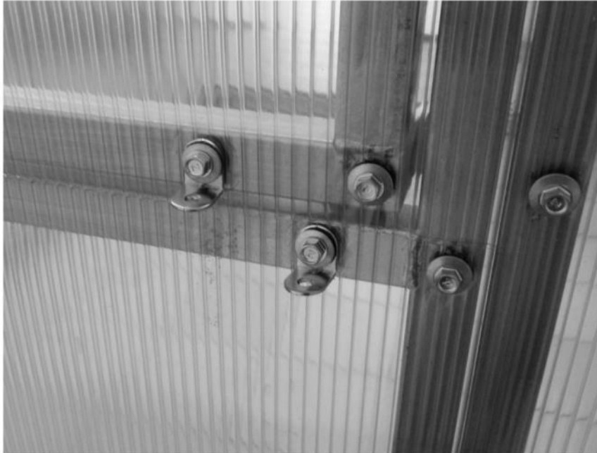
Рис. 10. Места крепления уголков форточки и двери
