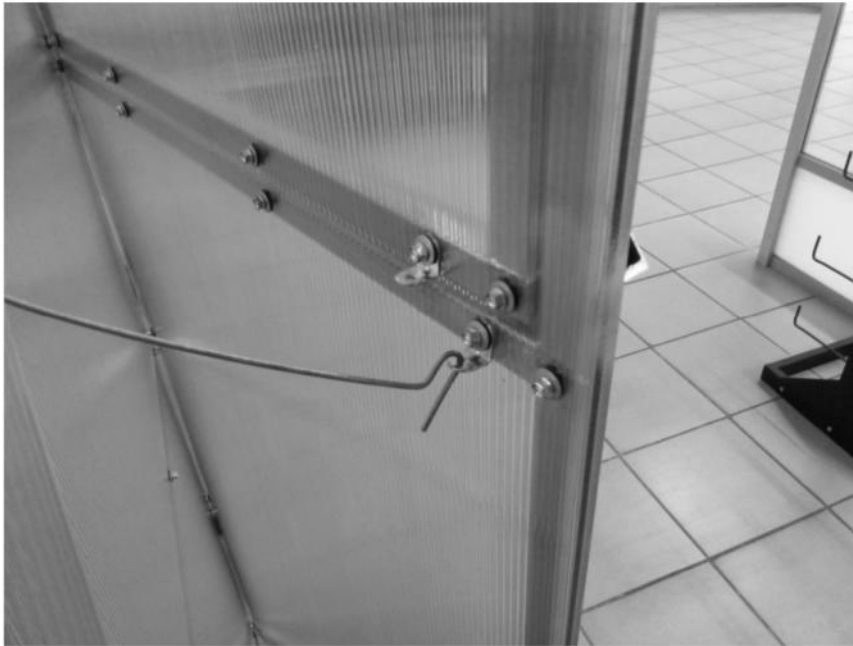
Рис. 12. Проверка фиксации крючка
