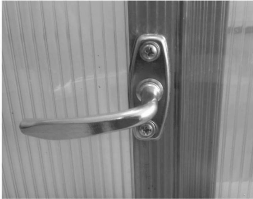
Рис. 7. Крепление ручки саморезами
